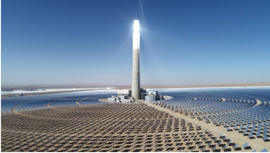
Cerro dominador (110 MW)
